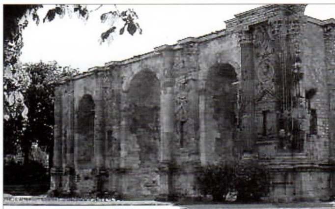
Fig. 132 a - Porte de Mars. La façade septentrionale actuellement (cl. R. Neiss)
